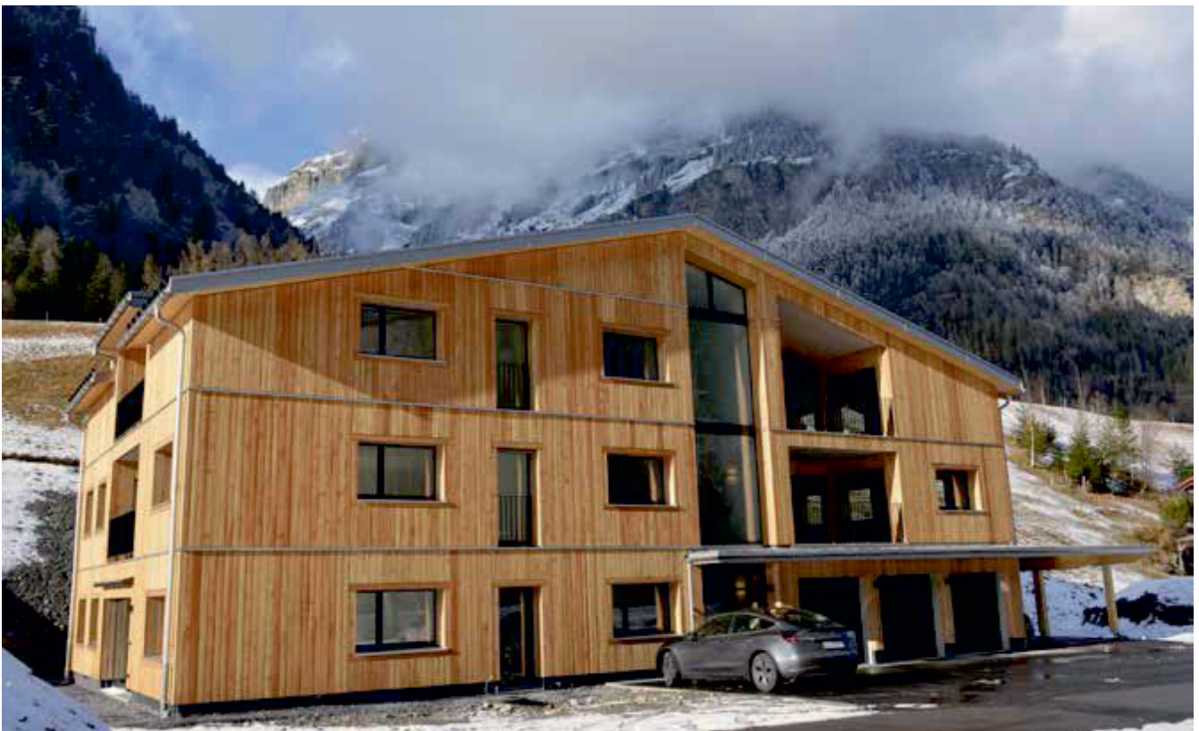
Neubau Mehrfamilienhaus Erdinos der WBG Taminatal
