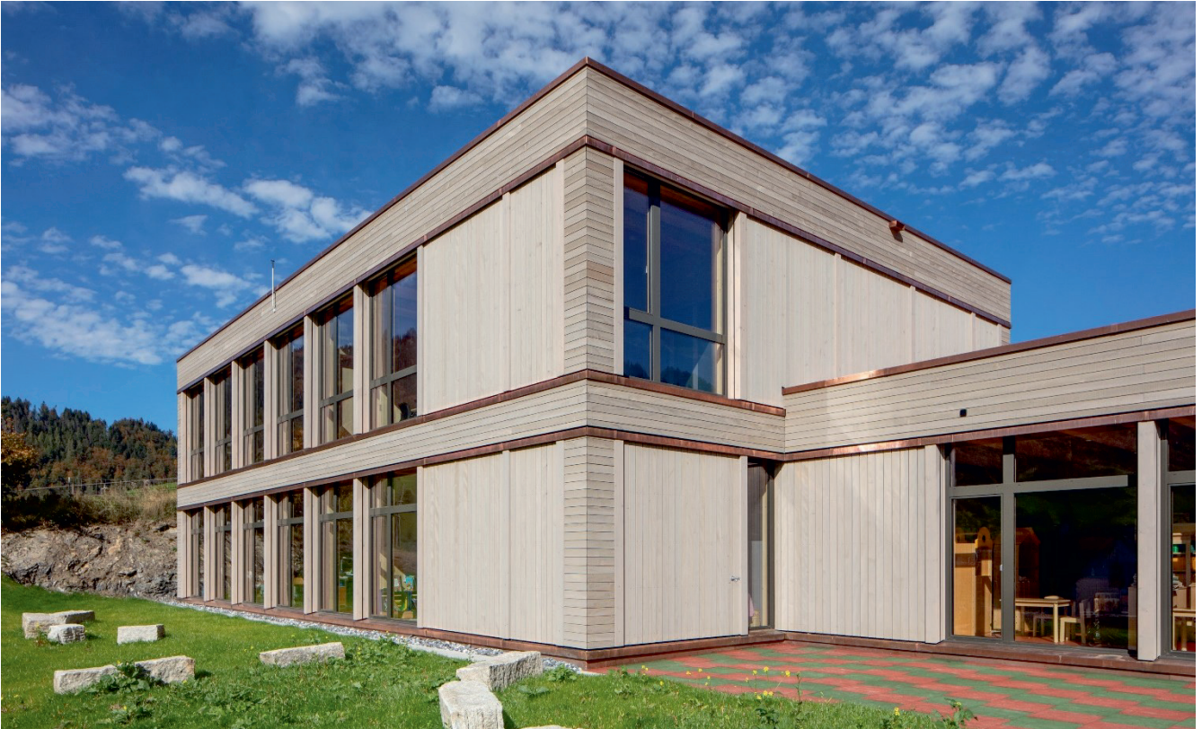
Neubau Kindergarten Bovel Pfäfers
